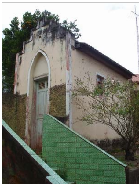
Fachada principal e lateral esquerda
