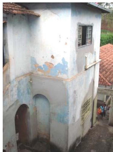
Fachada voltada para o pátio interno. Detalhe para as janelas modificadas. FOTO: Natália B.Campos, dez. 2007.
