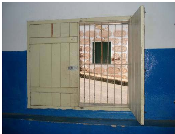
Janela voltada para a Rua da Máquina no porão. FOTO: Natália B.Campos, dez. 2007.
