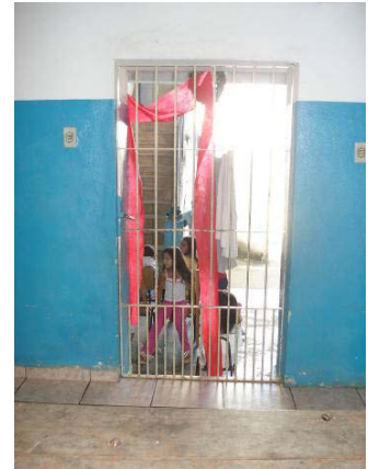
Segunda porta com gradil metálico que liga o porão com o pátio interno.
