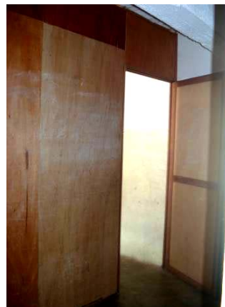
Porão - divisória de madeira. FOTO: Natália B.Campos, dez. 2007.
