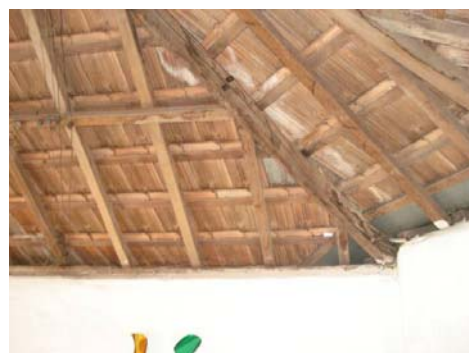
Pavimento térreo - forro da copa em telha vã. FOTOS: Natália B.Campos, dez. 2007.
