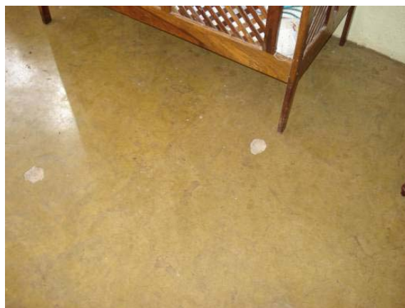
Piso em cimento queimado. FOTO: Natália B.Campos, dez. 2007.
