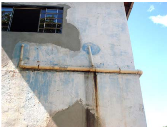
Detalhe da tubulação que desce pelo lado externo da edificação. FOTO: Natália B.Campos, dez. 2007.
