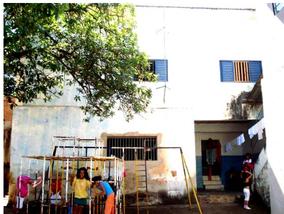
Fachada posterior voltada para o pátio interno. FOTO: Natália B.Campos, dez. 2007.
