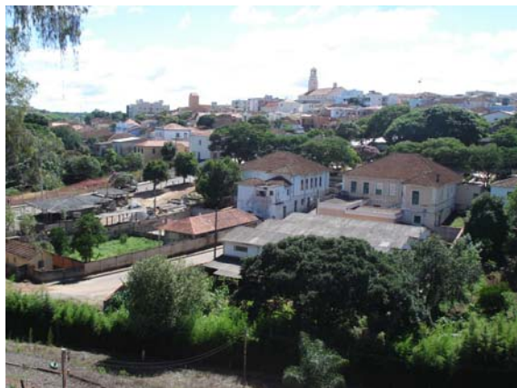
Vista geral da implantação do imóvel.
