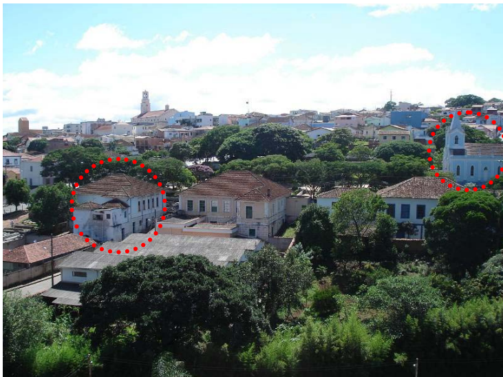
Foto do entorno. Em destaque a edificação em análise e a Igreja N. S. da Aparecida. FOTO: Natália B.Campos, dez. 2007.
