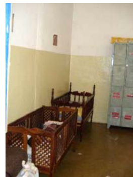
Pavimento térreo - quarto 08. FOTO: Natália B.Campos, dez. 2007.
