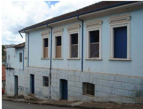
Fachada lateral direita, com as três entradas voltadas para a Rua da Máquina. FOTO: Natália B.Campos, dez .2007.
