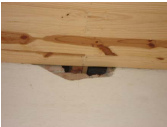
Forro em madeira tabuada. FOTO: Natália B.Campos, dez. 2007.
