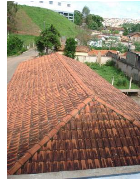
Telhado em quatro águas da área para festas. FOTO: Natália B.Campos, dez. 2007.
