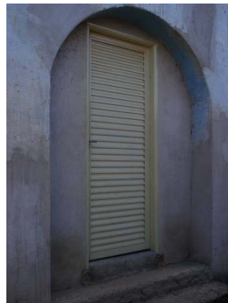
Porta metálica que leva ao depósito localizado logo abaixo da cozinha.
