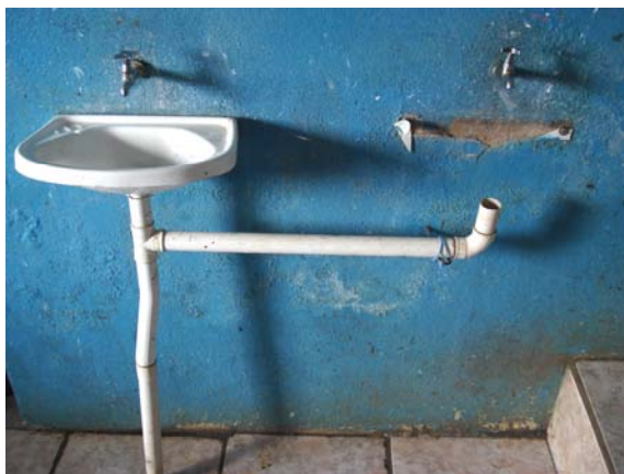
Pia localizada no porão ao lado da área de lavanderia. FOTO: Natália B.Campos, dez. 2007.
