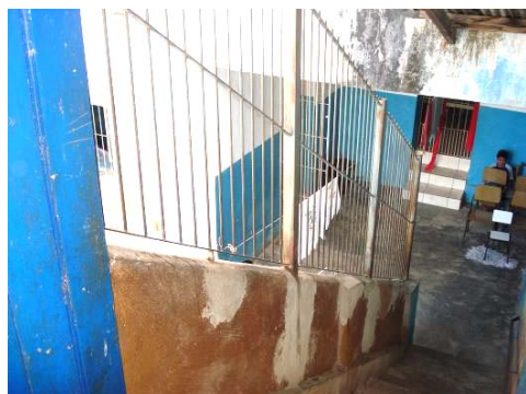
Escada externa – detalhe corrimão.
