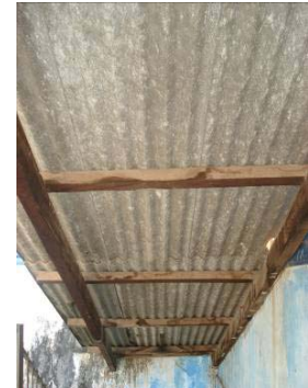
Detalhe telhado em telha metálica. FOTO: Natália B.Campos, dez. 2007.
