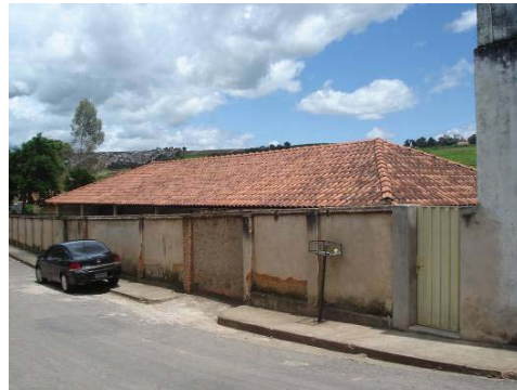
Portão no muro voltado para a Rua da Máquina que leva ao interior do lote. FOTO: Natália B.Campos, dez .2007.
