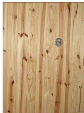
Forro existente na maior parte do pavimento térreo. FOTO: Natália B.Campos, dez. 2007.
