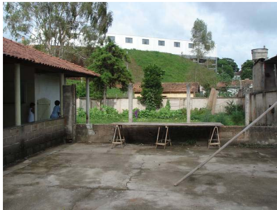
Pátio descoberto e área permeável. FOTO: Natália B.Campos, dez. 2007.
