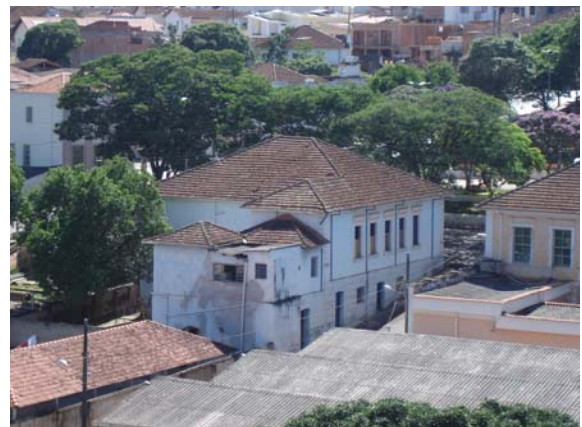
Vista geral do telhado.
