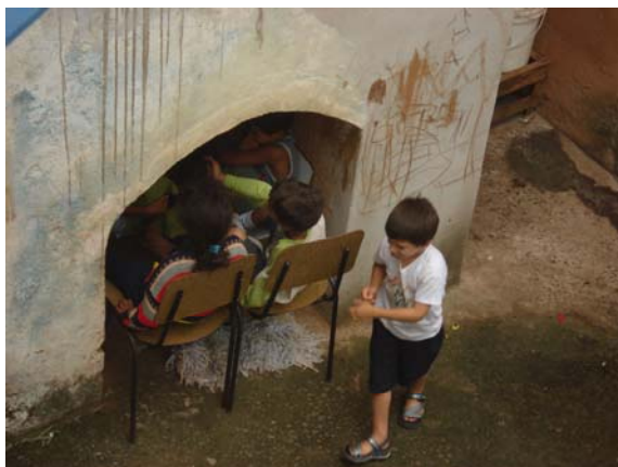
Nichos localizados na fachada lateral esquerda, voltada para o pátio. FOTO: Natália B.Campos, dez. 2007.
