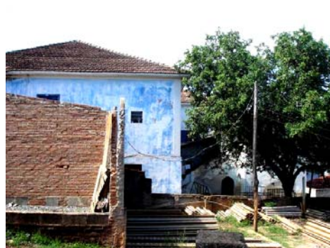
Fachada lateral esquerda.
