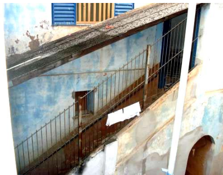
Detalhe escada externa com telhado em telha metálica. FOTO: Natália B.Campos, dez. 2007.
