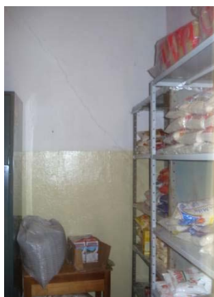
Depósito localizado dentro da sala da diretoria. FOTO: Natália B.Campos, dez. 2007.
