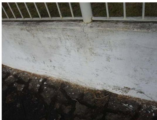
Base do muro de cercamento do bem apresenta trincas, descolamento da camada pictórica e manchas indicativas do acúmulo de umidade.
