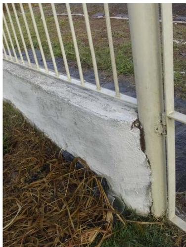
Vista de parte da base em alvenaria do muro de sustentação, acusando perda de parte do reboco.
