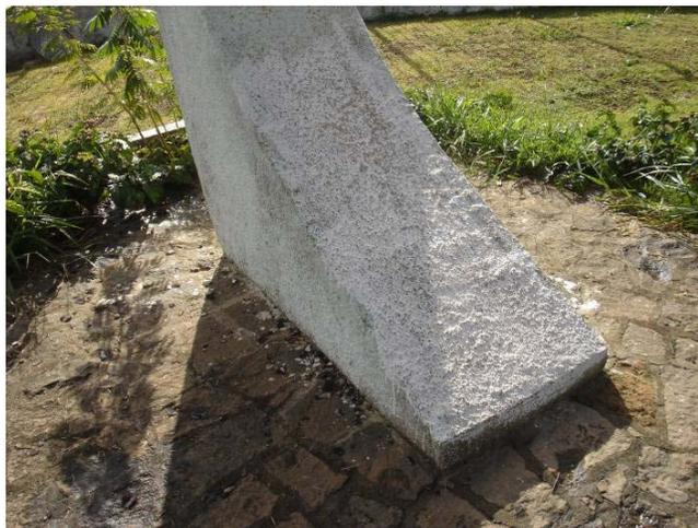
Vistas posterior e da base do pedestal de sustentação do avião apresentando manchas, marcas de sujeira e de revestimento posterior em apenas parte do elemento estrutural.
