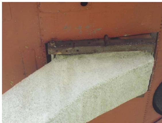
Detalhe da peça metálica de encaixe do pedestal com o avião, em bom estado de conservação, apesar de pequenas manchas.
