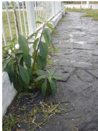
Piso que circunda o gradil de fechamento do bem: presença de vegetação gramínea e arbustiva por entre frestas do piso e entre o piso e a base de alvenaria do gradil.
