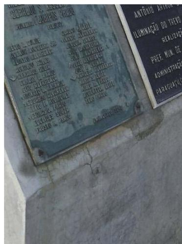
Vista geral e detalhe das duas placas metálicas fixadas à base de concreto, que apresenta trincas e manchas de oxidação no encontro do concreto com uma das placas, em razão do escoamento da água através desta, causando sua corrosão.
