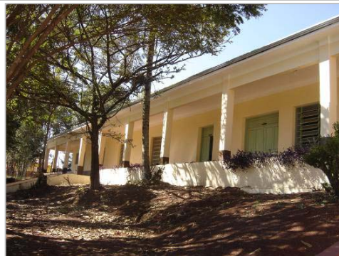
Edificação localizada no afastamento posterior
