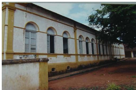
Fachada lateral esquerda antes da reforma de 2002 FONTE: Acervo particular da E.E. Pedro Leite
