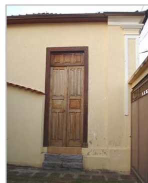
Porta principal, na fachada lateral direita
