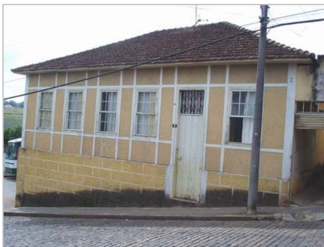
Fachada Principal FOTOS: Brana Carvalhaes, maio/2006
