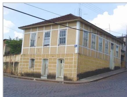
Fachada voltada para Rua Barão do Rio Branco
