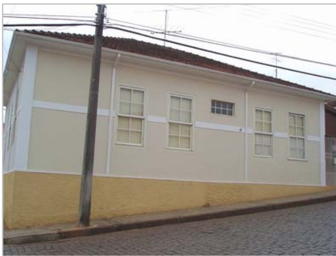
Fachada Principal, voltada para Rua Dr. João Pinheiro FOTOS: Brana Carvalhaes, maio/2006
