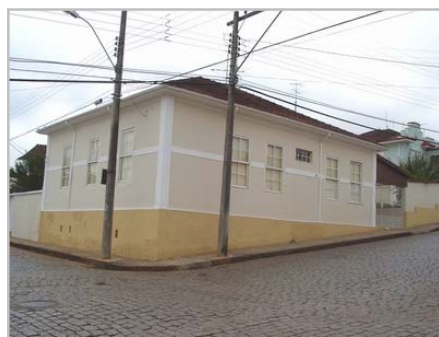
Fachada principal e voltada para Rua Paula Dias
