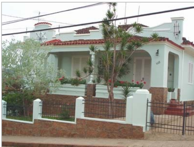
Fachada Principal FOTOS: Brana Carvalhaes, maio/2006
