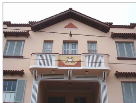
Detalhe da sacada no andar superior
