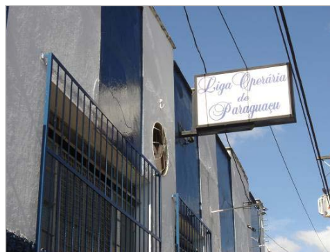
Detalhe do coroamento e da placa
