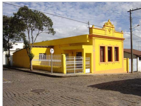
Edificação à Rua Pres. Getúlio Vargas, 316
