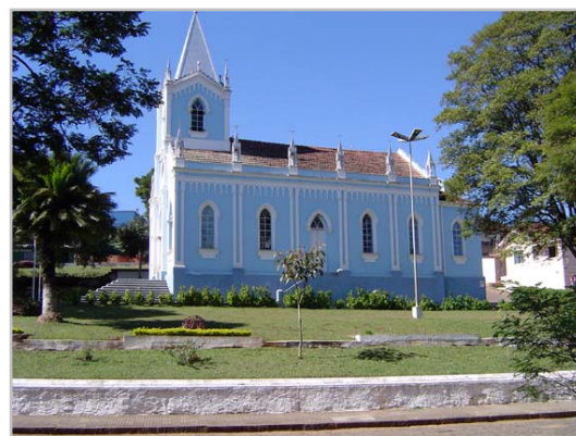
Fachada lateral esquerda
