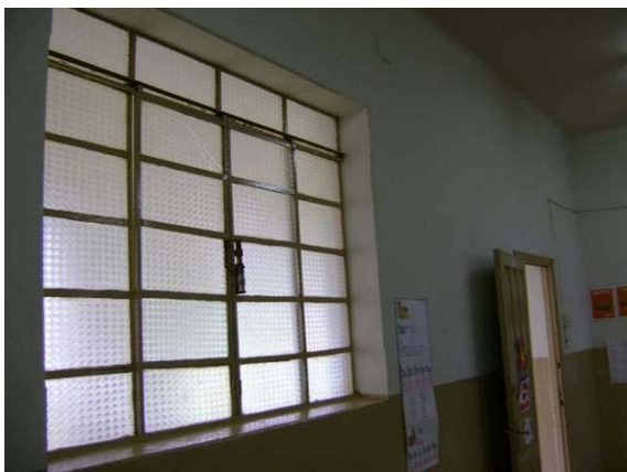
Janela de sala de aula em bom estado de conservação.
