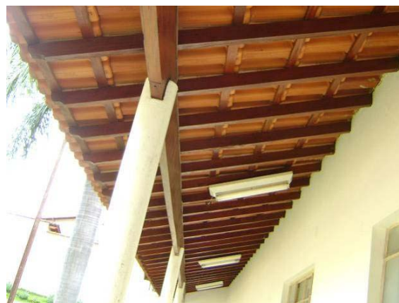
Vista do madeiramento da estrutura e das telhas da cobertura do bloco de salas à direita do bloco principal em ótimo estado de conservação.
