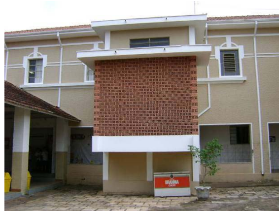
Tijolos furados conformando o fechamento da escada da varanda lateral direita bem conservados.
