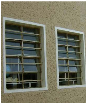
Enquadramentos simples em argamassa na fachada posterior em bom estado de conservação.
