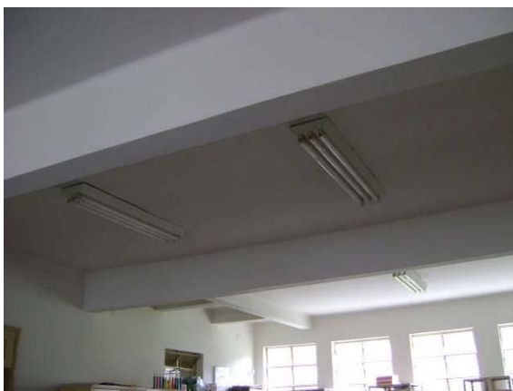
Vigas em ótimo estado de conservação.
