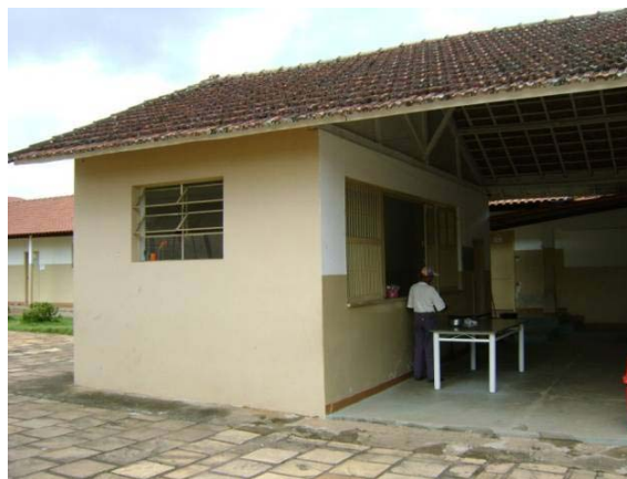
Vista da cozinha. IMAGEM: Thiago Fontes, fev/2010.
