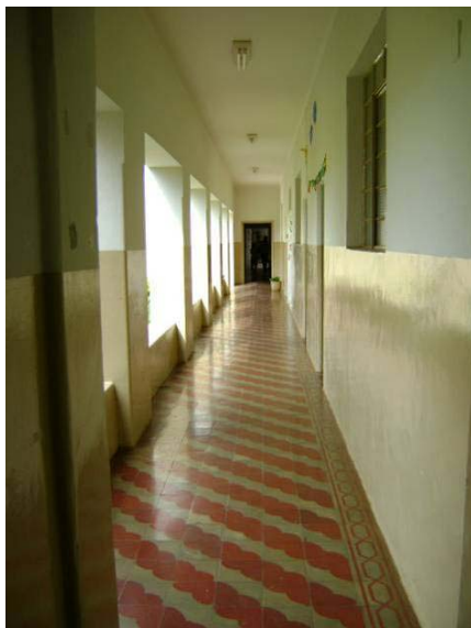
Piso em ladrilhos hidráulicos da varanda de circulação, em ótimo estado de conservação.
