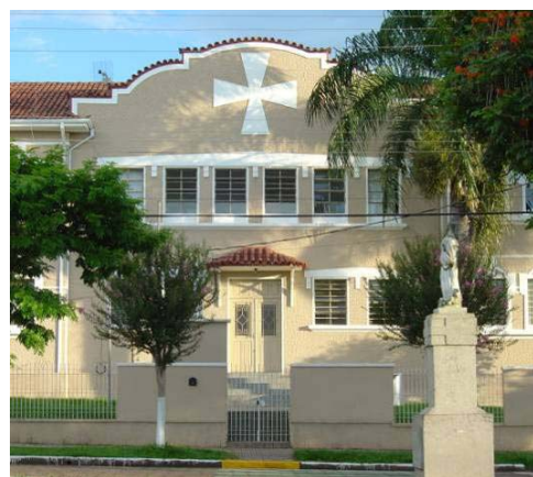
Plano central da fachada da antiga FEDEOP, que apresenta o frontão e a porta central de acesso. IMAGEM: Carolina Belcufine, fev/2010.
