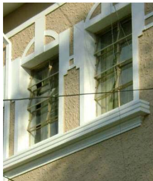
Enquadramentos trabalhados em argamassa na fachada frontal em bom estado de conservação.
