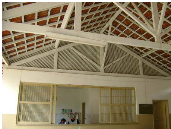
Janela ampla do balcão da cantina.
