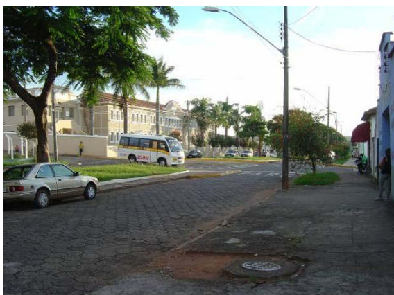
Vista da Avenida Dom Bosco. Notam-se amplas calçadas, embora com alguns danos no calçamento.
