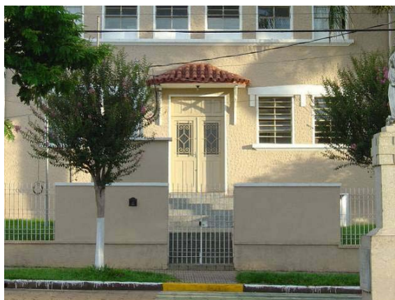
Portão de entrada principal.
