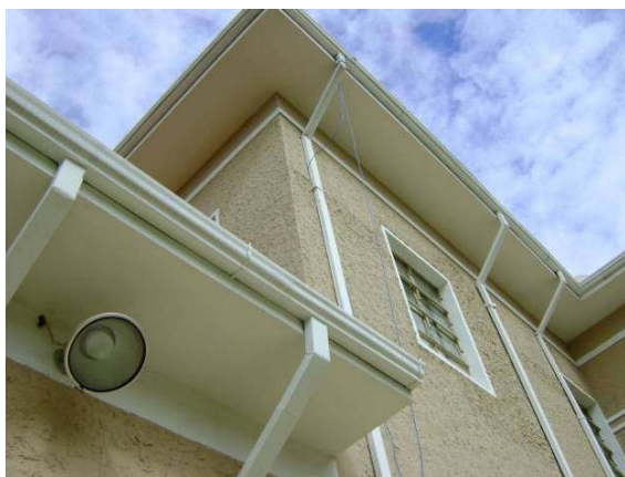
Vista e detalhe dos beirais em laje de concreto, calhas e condutores, ambos em bom estado de conservação.
