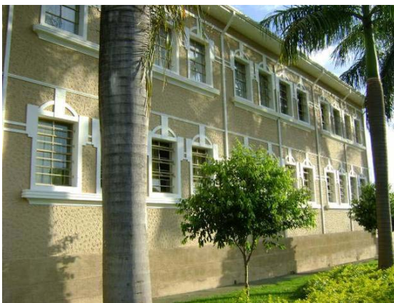
Os enquadramentos das janelas, no geral, encontram-se em bom estado de conservação.
