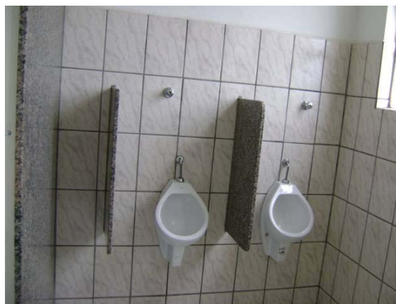
Vista de instalação sanitária do bloco central do pavimento superior. IMAGEM: Thiago Fontes Pereira, fev/2010.
