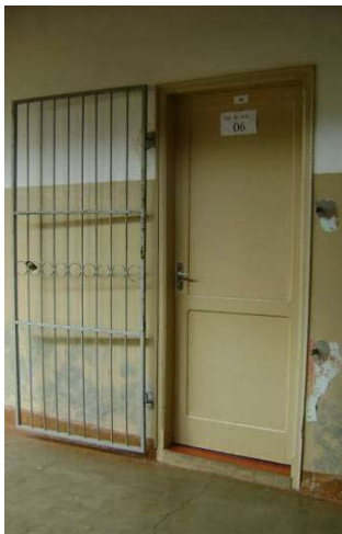
Porta de sala de aula do bloco à esquerda do edifício principal.
