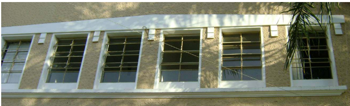
Detalhe do enquadramento das janelas no plano frontal. IMAGEM: Thiago Fontes Pereira, fev/2010.
