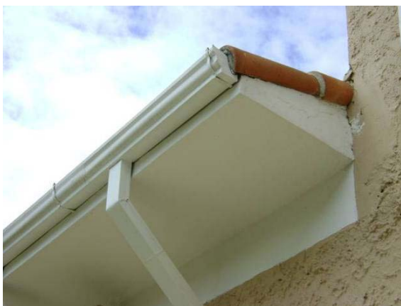
Vista e detalhe dos beirais em laje de concreto, calhas e condutores, ambos em bom estado de conservação.
