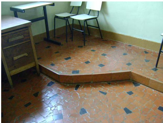
Piso em peças cerâmicas de sala de aula, em ótimo estado de conservação
