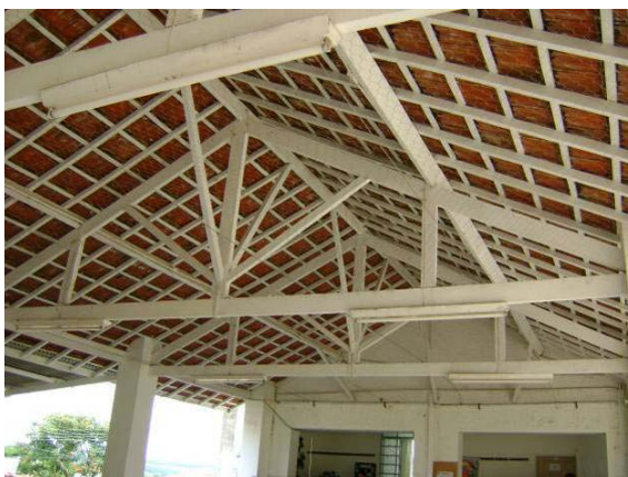
Vista da estrutura da cobertura da cantina, em ótimo estado de conservação.
