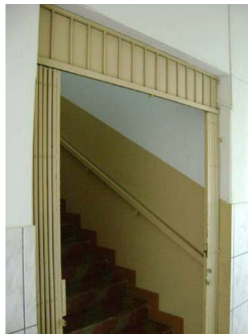
Porta metálica de acesso à escada da varanda de circulação.
