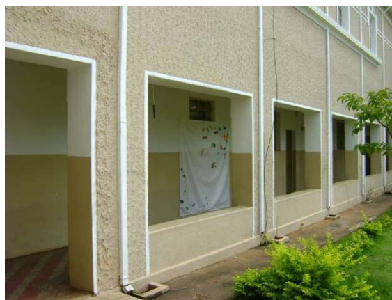
Vista dos pilares da varanda de circulação externa, em bom estado de conservação.
