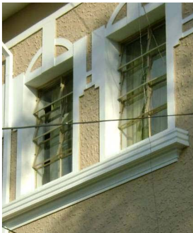
Enquadramentos trabalhados em argamassa na fachada frontal em bom estado de conservação.
