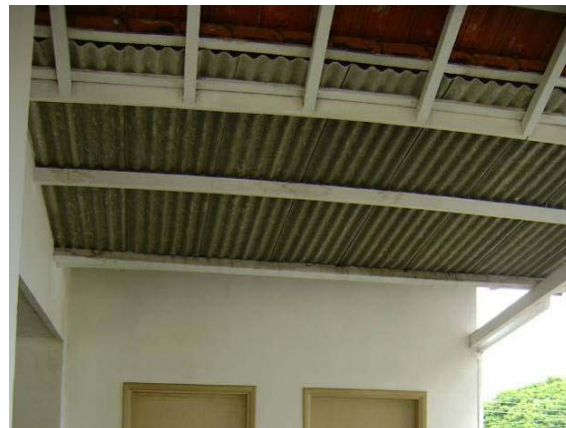
Vista de seção de telhas de fibrocimento em frente ao bloco mais recente de banheiros, em bom estado de conservação.
