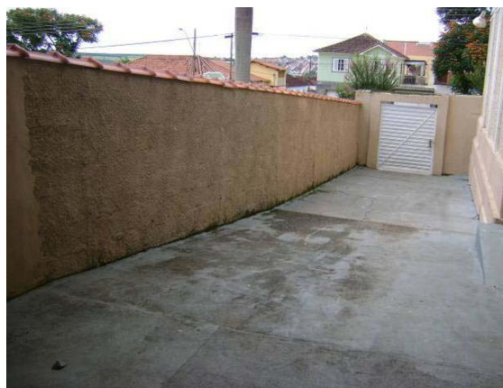
Piso cimentado em bom estado de conservação, apesar de apresentar desgaste superficial.
