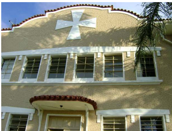
Frontão central do edifício principal da Escola Municipal Luiz de Melo Viana Sobrinho em ótimo estado de conservação.
