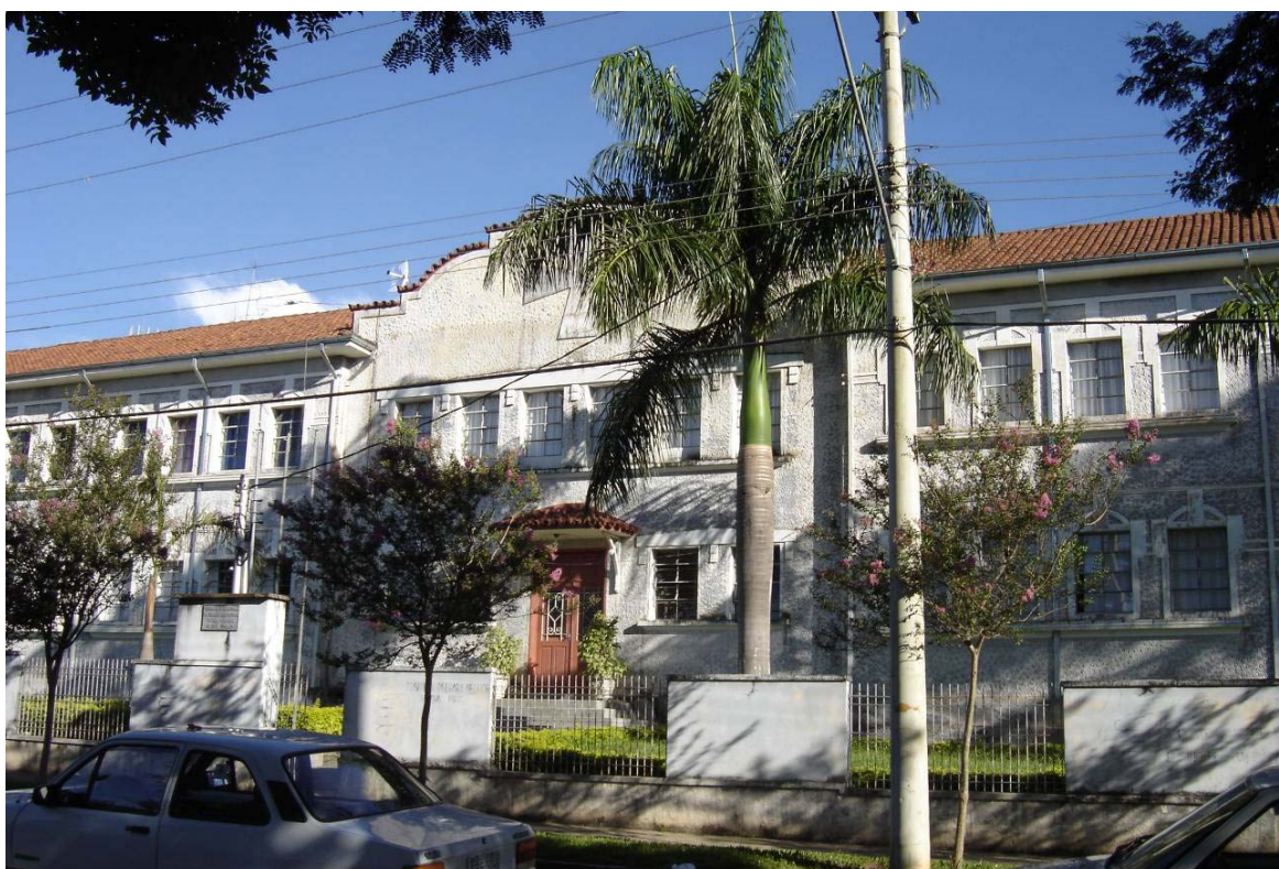
Edifício da FEDEOP. 2005. IMAGEM: Alexandre Borim, jan/2005.
