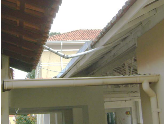
Vista de diferentes tipos de calhas e condutores na edificação.
