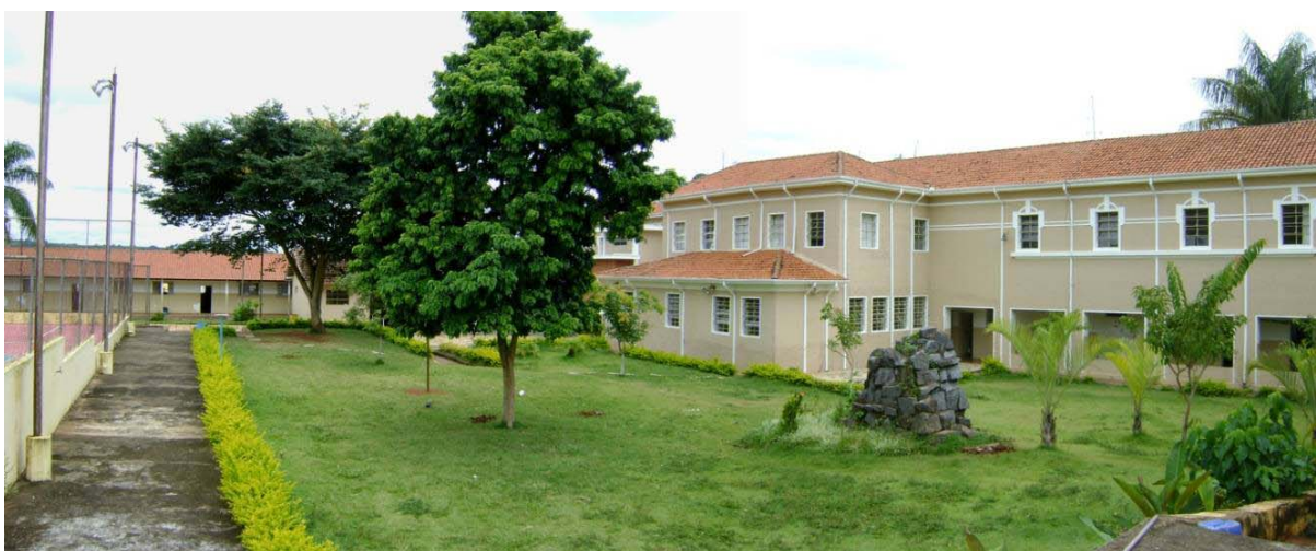
Vista do geral do pátio, com a quadra à esquerda, o bloco lateral de salas ao fundo e o prédio principal da Escola Municipal Luiz de Melo Viana Sobrinho à direita. IMAGEM: Thiago Fontes, fev/2010.
