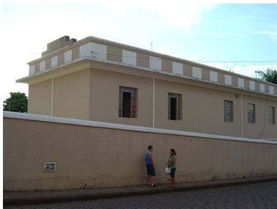
Vista da platibanda do edifício da biblioteca. Esta se encontra muito bem conservada, apesar de apresentar manchas escuras nas faces laterais dos beirais e da empena posterior.
