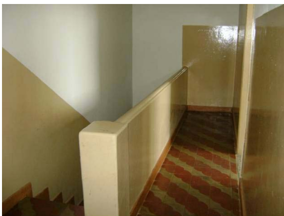
Vista da escada que dá acesso do hall ao pavimento superior. IMAGEM: Thiago Fontes Pereira, fev/2010.
