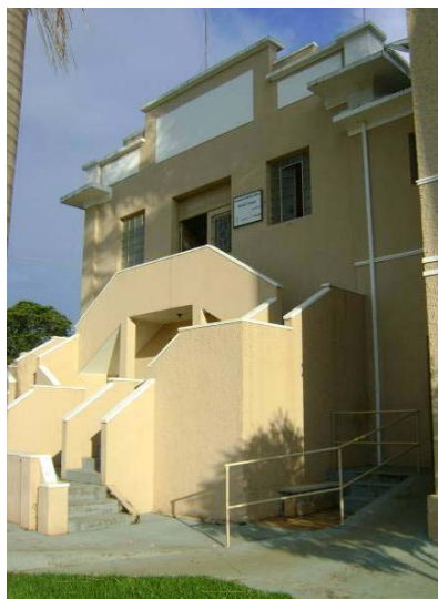
Escada de acesso principal ao prédio da biblioteca.
