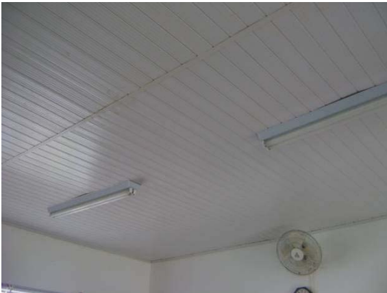
Forro em PVC de sala de aula, em ótimo estado de conservação.
