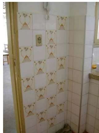
Seção de peças cerâmicas da cozinha, também em ótimo estado de conservação.
