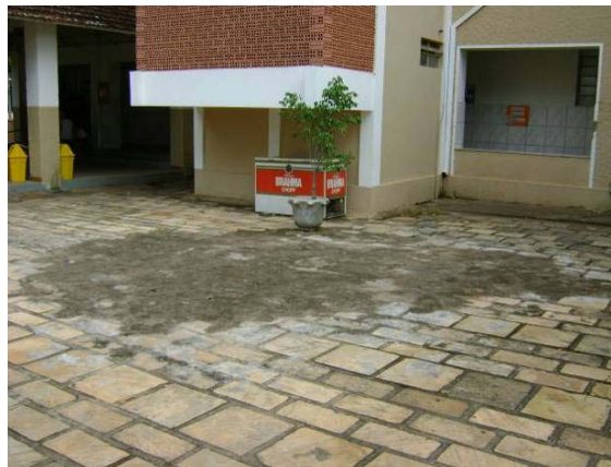
Piso lajeado do pátio em bom estado de conservação, apesar de mostrar uma grande mancha cimentícia.
