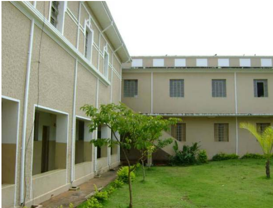
Paredes de alvenaria do prédio principal da Escola Municipal Luiz de Melo Viana Sobrinho e Biblioteca pública em ótimo estado de conservação.
