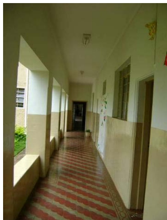
Vista da varanda de circulação lateral, apresentando revestimento em ótimo estado de conservação.
