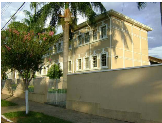
Vista do muro que cerca a Escola Municipal Luiz de Melo Viana Sobrinho.
