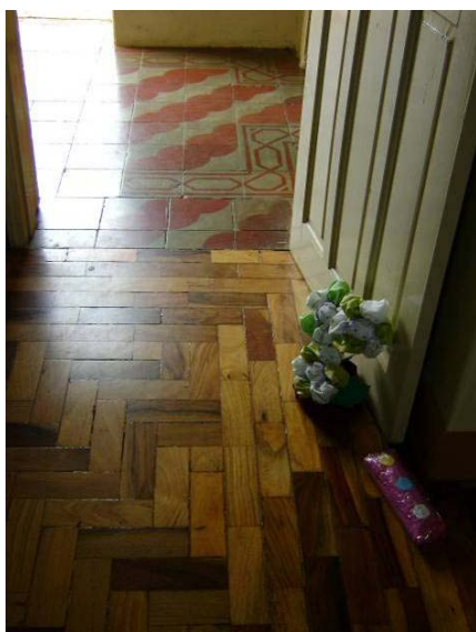
Piso em taco da sala da diretoria.
