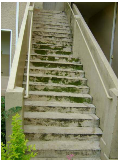
Escada que liga o pátio à biblioteca.
