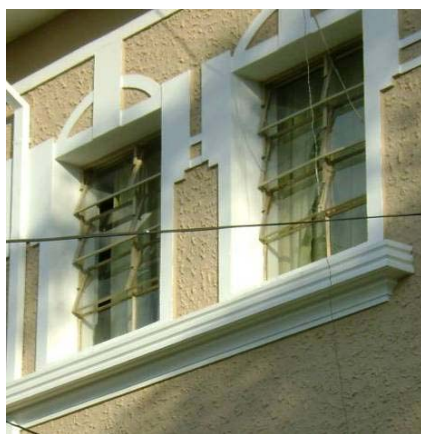
Detalhe do enquadramento das janelas da fachada frontal do edifício principal da Escola Mun. Luiz de Melo Viana Sobrinho. IMAGEM: Thiago Fontes Pereira, fev/2010.
