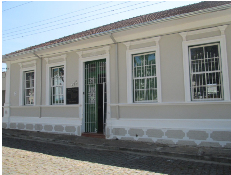
Foto 02: fachada principal. Outubro de 2017. Bárbara Pereira Mançanares.
