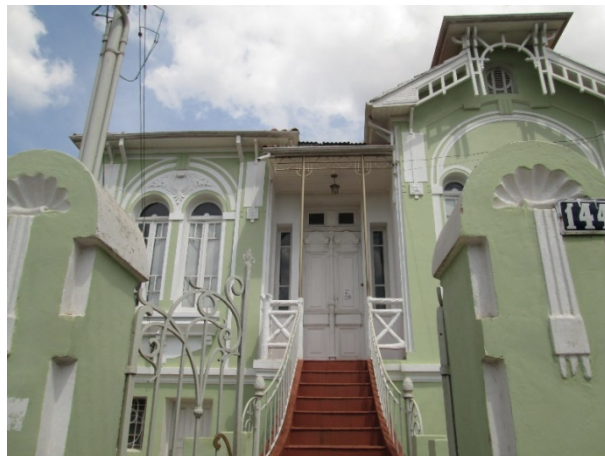
Imagem 03: edificação localizada à Praça Oswaldo Costa – detalhe da escada de acesso. Outubro de 2018. Bárbara Pereira Mançanares.
