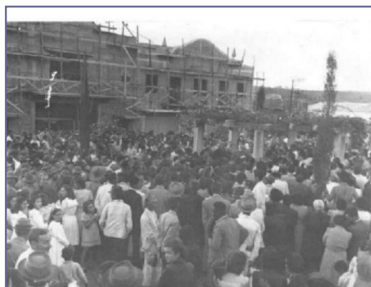
O imóvel em construção na década de 1940. FOTO: CD-ROM: Paraguaçu: sua história, sua gente. Paraguaçu/MG: 2004
