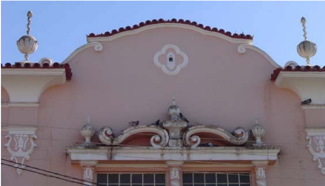
Foto 02: detalhe – parte superior da fachada. Alexandre Borim. Julho de 2005.
