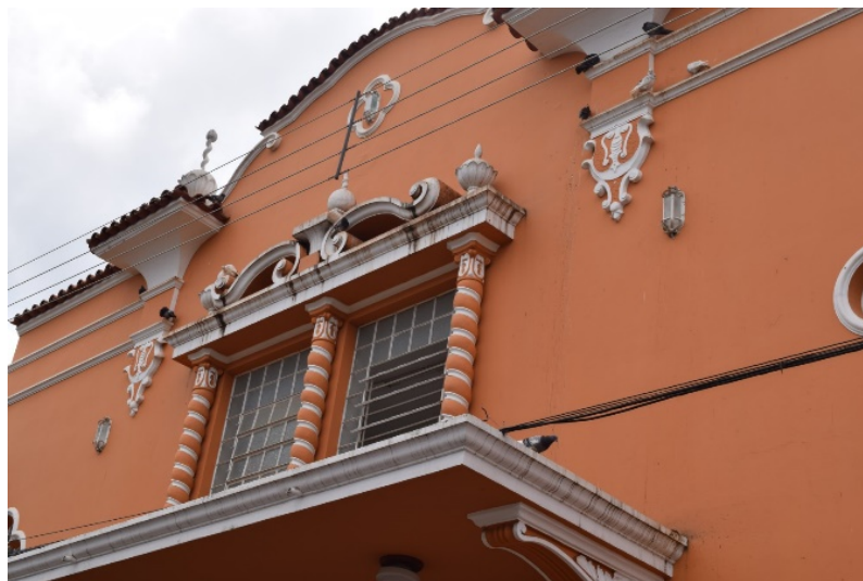
Foto 02: Teatro Municipal Donato Leite de Andrade – detalhe da parte superior. Novembro de 2017. Lorrana Negretti Ferreira.
