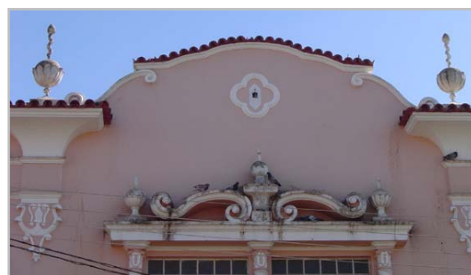
Detalhe - parte superior da fachada
