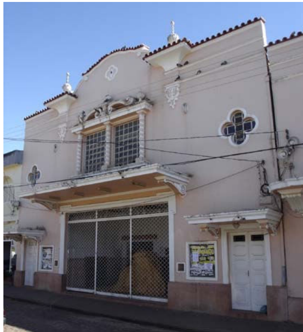
Foto 01: fachada principal. Alexandre Borim. Julho de 2005.
