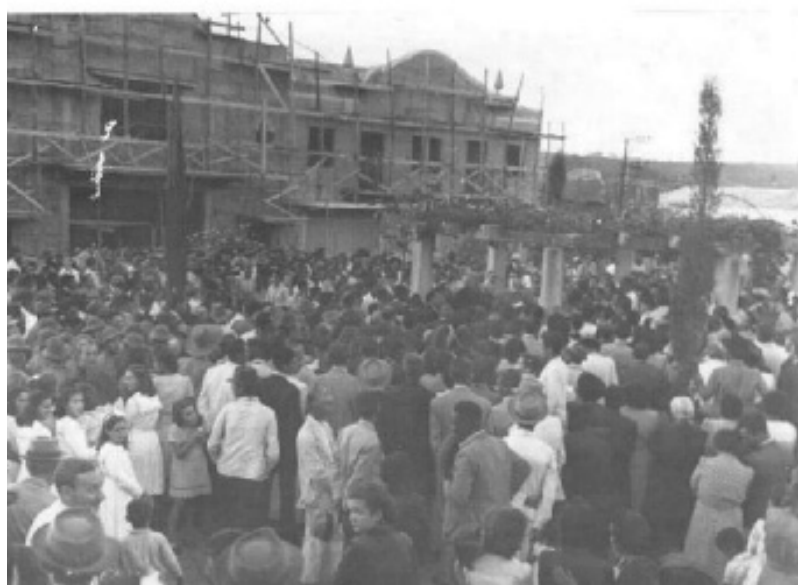
Foto 04: imóvel em construção na década de 1940. CD-ROM: Paraguaçu: sua história, sua gente. Paraguaçu/MG: 2004.
