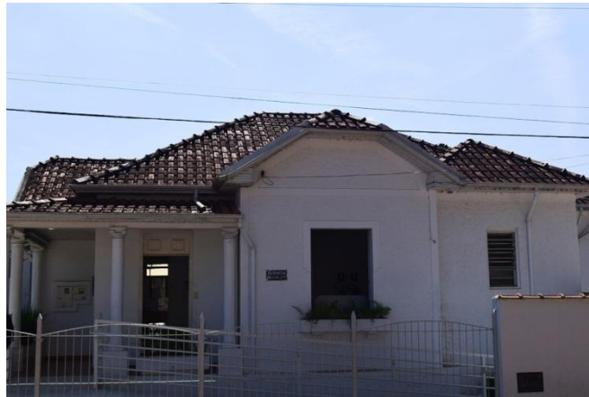
Imagem 07: edificação localizada à Praça Oswaldo Costa nº 314 – fachada da avenida Gonçalves Leite. Bárbara Pereira Mançanares. Setembro de 2019.
