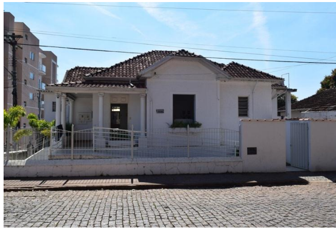
Imagem 06: edificação localizada à Praça Oswaldo Costa nº 314 – fachada da avenida Gonçalves Leite. Bárbara Pereira Mançanares. Setembro de 2019.
