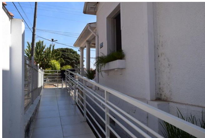
Imagem 08: edificação localizada à Praça Oswaldo Costa nº 314 – rampa de acessibilidade com entrada pela fachada da Avenida Gonçalves Leite. Bárbara Pereira Mançanares. Setembro de 2019.
