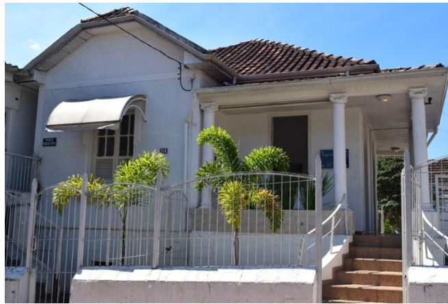
Imagem 03: edificação localizada à Praça Oswaldo Costa nº 314 onde está localizado o Cartório de Registro de Imóveis – acesso escada. Bárbara Pereira Maçanares. Setembro de 2019.
