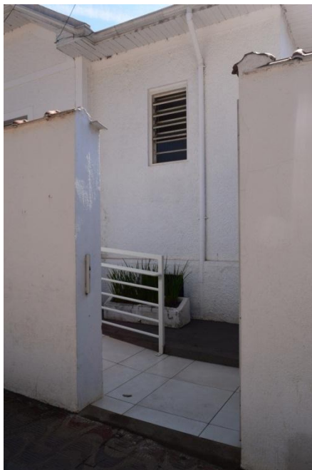
Imagem 09: edificação localizada à Praça Oswaldo Costa nº 314 – rampa de acessibilidade com entrada pela fachada da Avenida Gonçalves Leite. Bárbara Pereira Mançanares. Setembro de 2019.
