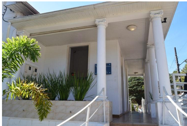
Imagem 04: edificação localizada à Praça Oswaldo Costa nº 314 – corrimão na escada e espelho em porta inutilizada. Bárbara Pereira Maçanares. Setembro de 2019.
