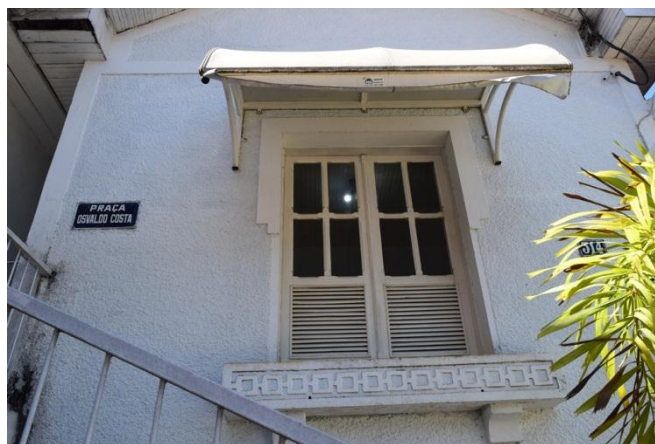
Imagem 05: edificação localizada à Praça Oswaldo Costa nº 314 – detalhe janela, toldo e jardineira. Bárbara Pereira Maçanares. Setembro de 2019.
