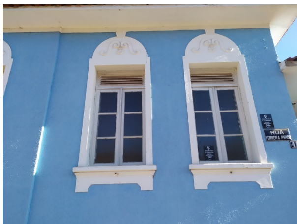
Imagem 04: edificação à Rua Ferreira Prado nº 413 – detalhe das janelas fechadas. Agosto de 2020.
