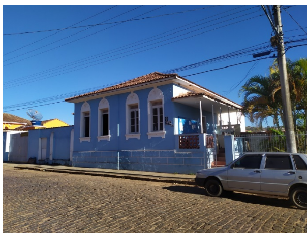
Imagem 01: edificação à Rua Ferreira Prado nº 413. Agosto de 2020. Bárbara Pereira Mançanares.
