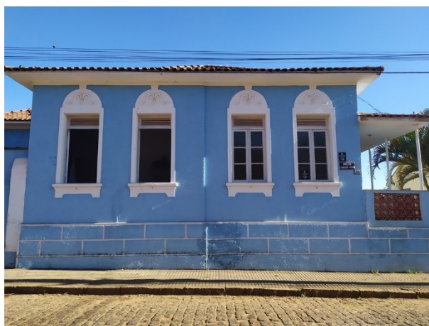
Imagem 02: edificação à Rua Ferreira Prado nº 413. Agosto de 2020. Bárbara Pereira Mançanares.
