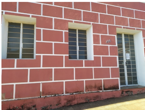
Imagem 05: Edificação à Rua Ferreira Prado nº 426 com a Rua Tiradentes nº 09 e 15, apartamentos 01 e 02 – detalhe da parte comercial no piso inferior. Agosto de 2020. Bárbara Pereira Mançanares.
