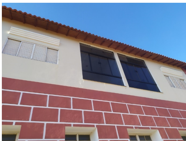
Imagem 04: Edificação à Rua Ferreira Prado nº 426 com a Rua Tiradentes nº 09 e 15, apartamentos 01 e 02 – detalhe das janelas no piso superior. Agosto de 2020. Bárbara Pereira Mançanares.
