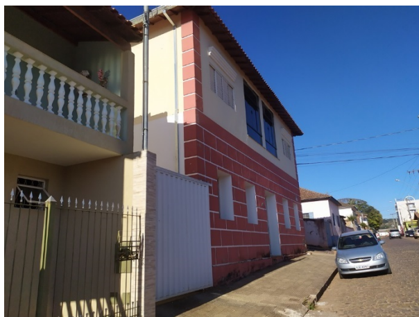
Imagem 03: Edificação à Rua Ferreira Prado nº 426 com a Rua Tiradentes nº 09 e 15, apartamentos 01 e 02 – Rua Ferreira Prado. Agosto de 2020. Bárbara Pereira Mançanares.
