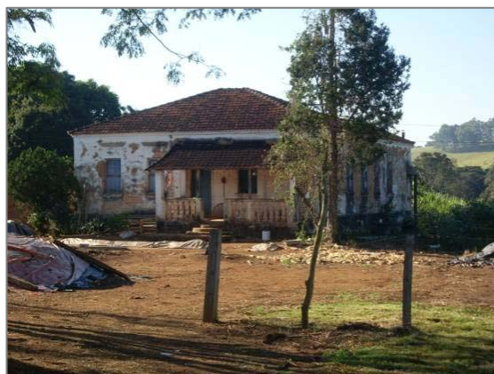
Vista geral da edificação. IMAGEM: Bruna Lima, mai/2008.
