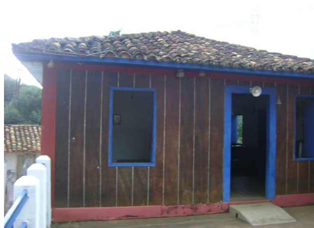
Trecho da fachada frontal da “parte original” com pintura falseando madeira.
