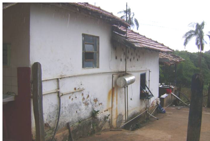
Vista de trecho da fachada lateral esquerda. IMAGEM: Luiz Felipe Brito, fev/2011.
